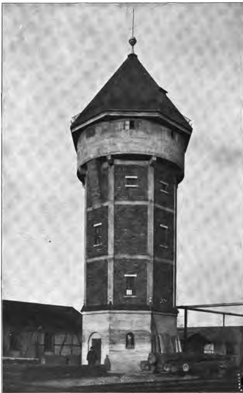
Abb. 28. Wasserturm in Kirchseeon, Oberbayern. Arch. Gebr. Rank.
